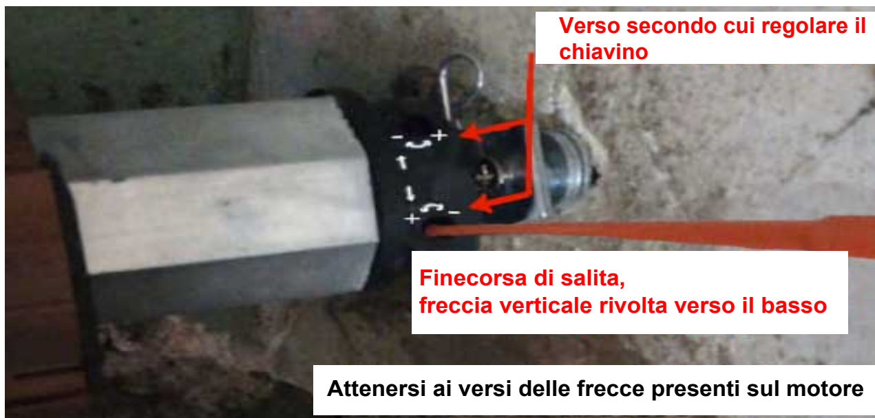
motore installato a destra
