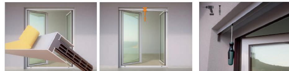
Posizionare la guida superiore con l'utilizzo del nastro adesivo. L'avvitamento è facoltativo
