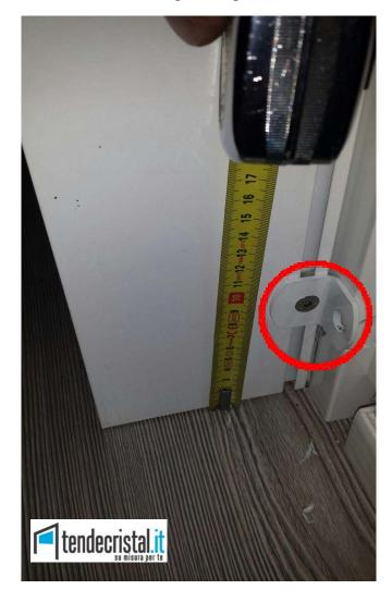
Particolare non previsto nel modello con cassonetto quadro. La vite dovrà essere inserita all'interno della guida.
